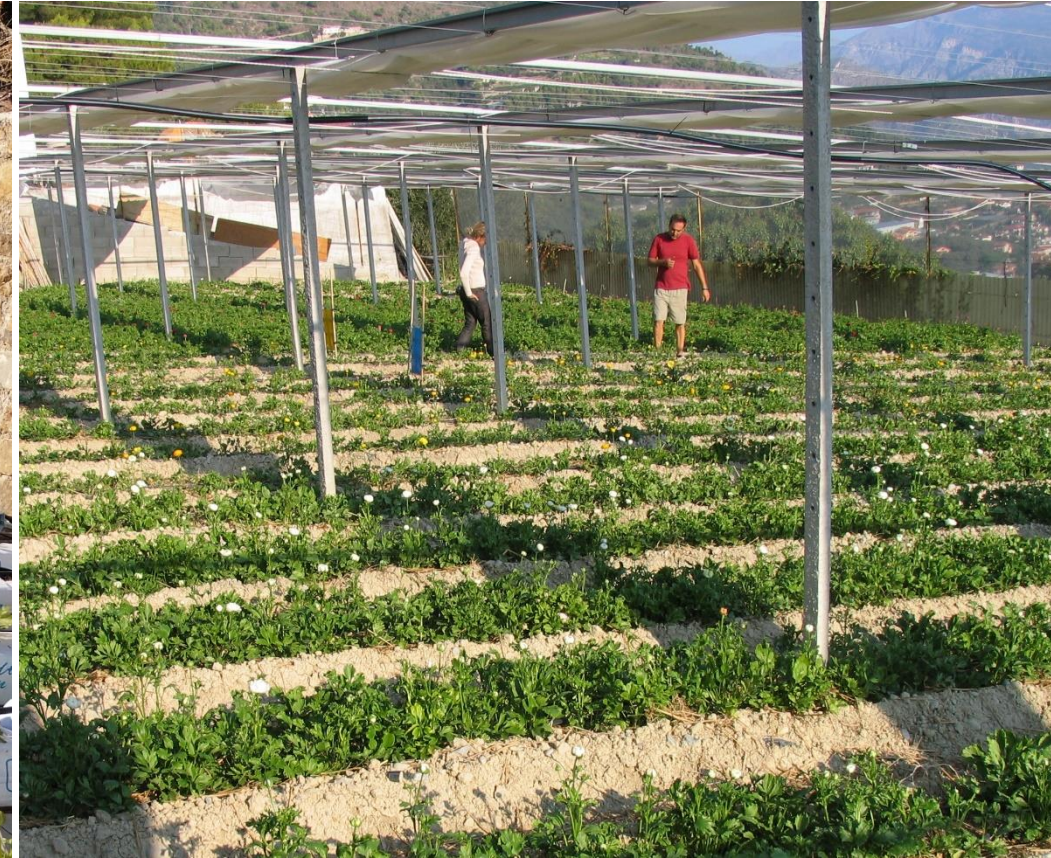
Panoramica impianto piena terra (Ventimiglia, IM)
